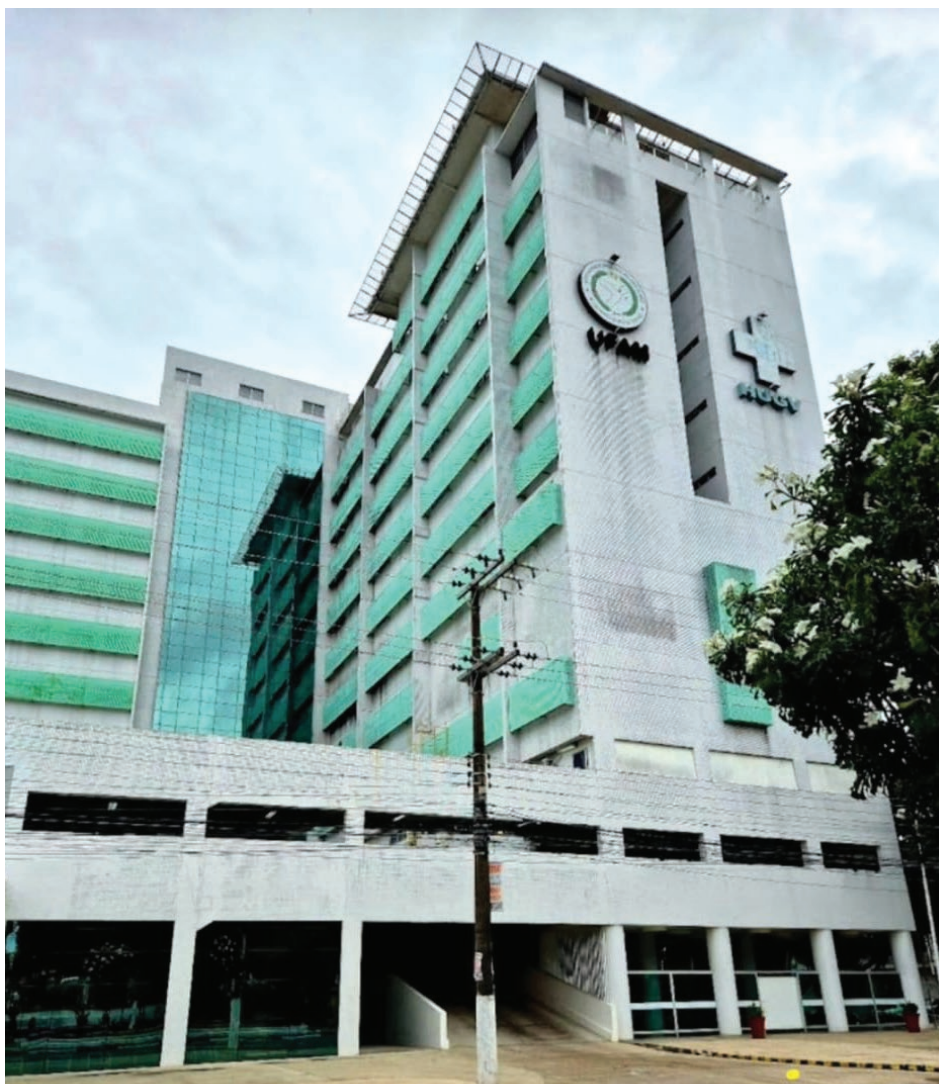
Hospital Vila da Serra
